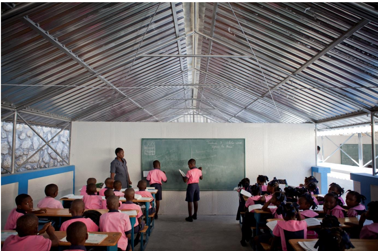
Haïti: de campagne droeg bij tot de bouw van 200 semipermanente scholen in Haïti. Ze weerstaan cyclonen en aardbevingen.
